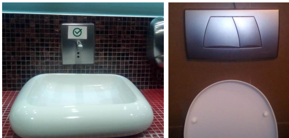
Εικόνα 9: Συστήματα εξοικονόμησης νερού στο Mediterranean Cosmos
