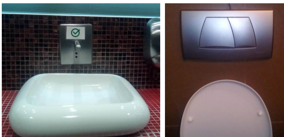
Εικόνα 9: Συστήματα εξοικονόμησης νερού στο Mediterranean Cosmos
